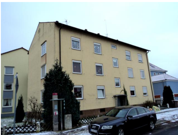
Wohnhaus vor der Sanierung
